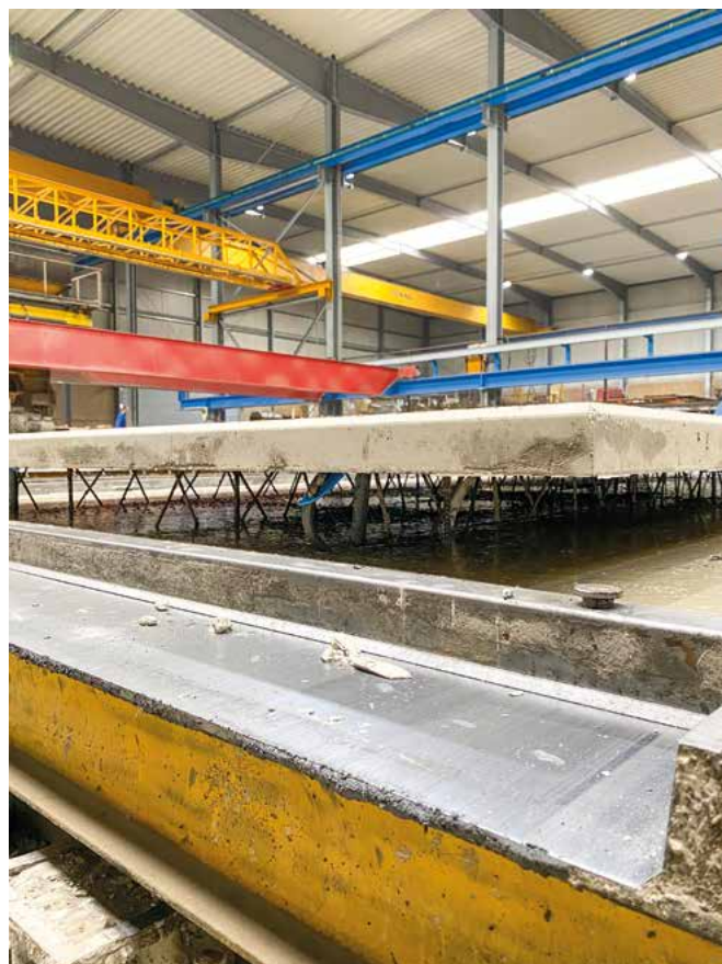
Les prémurs et dalles préfabriquées en béton sont renforcés par les raidisseurs fabriqués en usine et seront bétonnés sur chantier.
